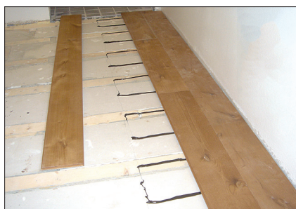
Lämpökäsittelyn, 15 mm, lattian asennus kantavan lattian päälle, lattiassa lattialämmitys.
