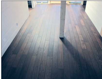
Valmis lämpökäsitelty tammi, kosteantilan lattia.
