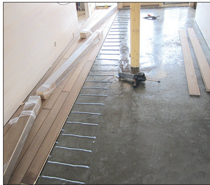
Kosteantilan lattian asennus.
